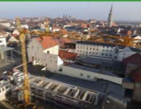
Die Bauarbeiten laufen auf Hochtouren
